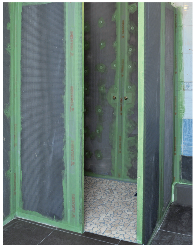
Nach dem Abdichten der Wände und der Verbindungsfugen, sind die Bauplatten verlegebereit.
