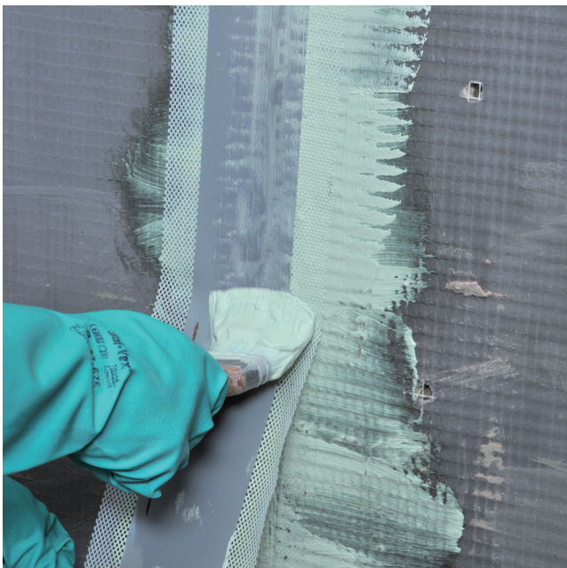
Das Dichtband in das noch frische CERMICRYL eindrücken.
