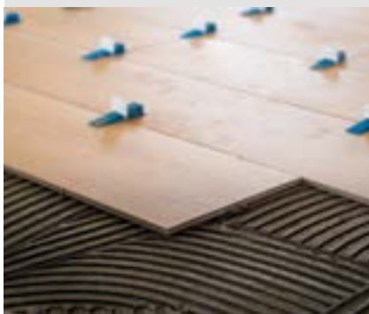
POSE DE CARRELAGE FLIESENVERLEGUNG
