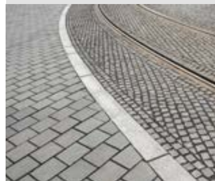
TRAVAUX DE GÉNIE CIVIL TIEFBAU
