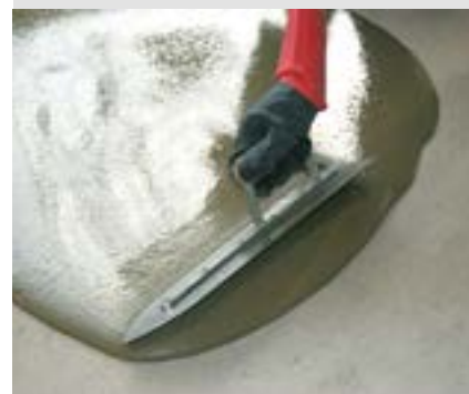
PRÉPARATION DE SOL VORBEREITUNG DES UNTERGRUNDS
