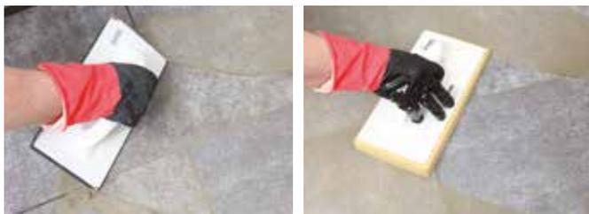
Gâcher 5 kg de CERMIJOINT SOUPLE avec 0,8 à 0,9 litres d'eau. Application avec une raclette en caoutchouc en appuyant fortement afin que les joints se remplissent dans toute leur profondeur. Nettoyage avec une éponge mousse légèrement humide (Utiliser le KITAJOINT). Nous conseillons de travailler par gâchée de petites quantités afin de respecter la durée pratique d'utilisation (40 min à 20°C).
